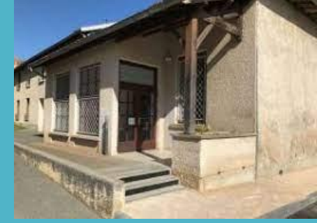
Accueil de loisirs « La Passerelle » (10-13 ans) Salle Marc Julien
